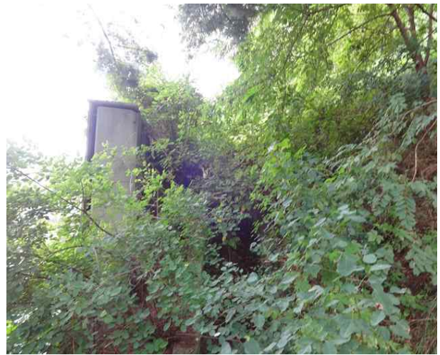
강릉측 사면 및 배수로 전경
