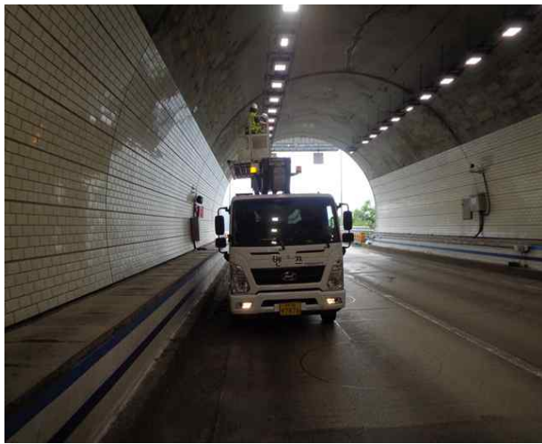
점검차를 이용한 근접조사
